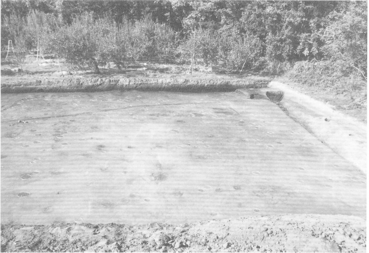
調査区（北西部分）
