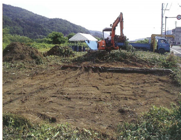
バックホーによる表土除去
