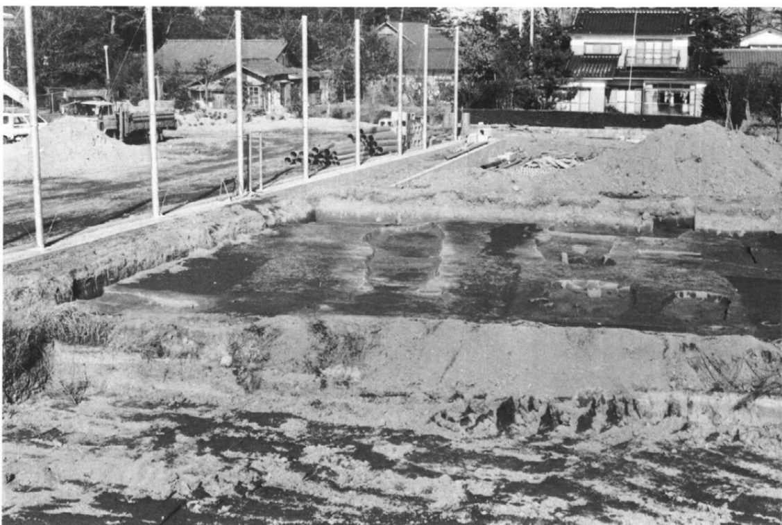
第1発掘面（西部） 手前の一段低い面はⅨ層（第2発掘面）である。撮影後は第1発掘面を同じ高さまで掘り下げて調査を行った。
