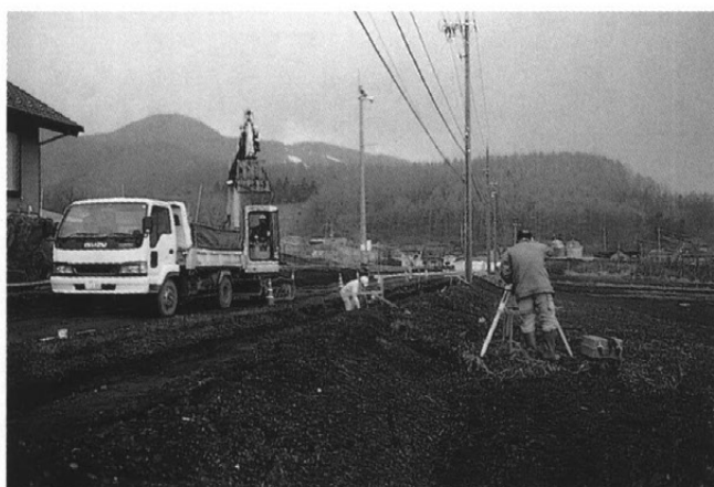
測量作業風景(道路工事がせまる)
