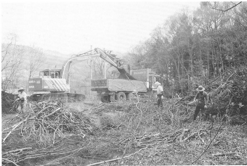
◀ 樹木かたづけ 重機による表土はぎ
