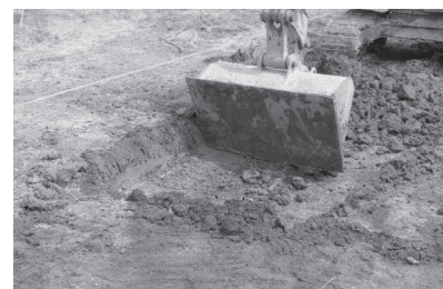
重機による表土の掘削
