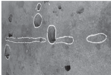
SD50の全景(西から)
