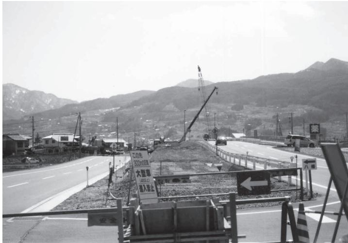
佐野川橋梁の工事(平成 16 年)
