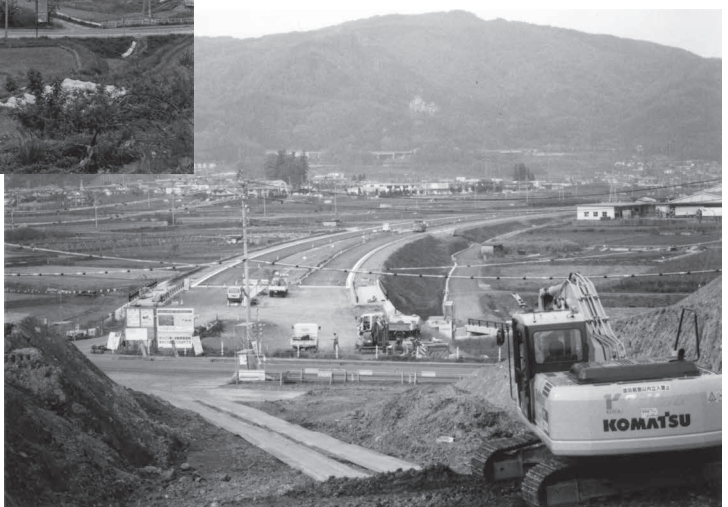
バイパス建設中の風景 (姨捨停車場線・峯謡坂から)
