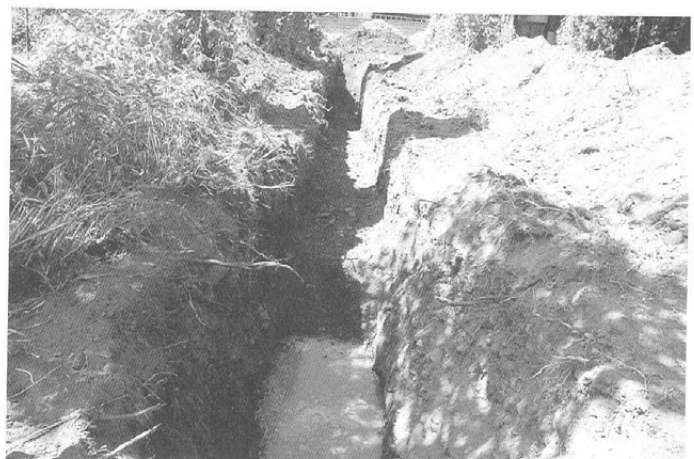
トレンチ検出状況 (東より)
