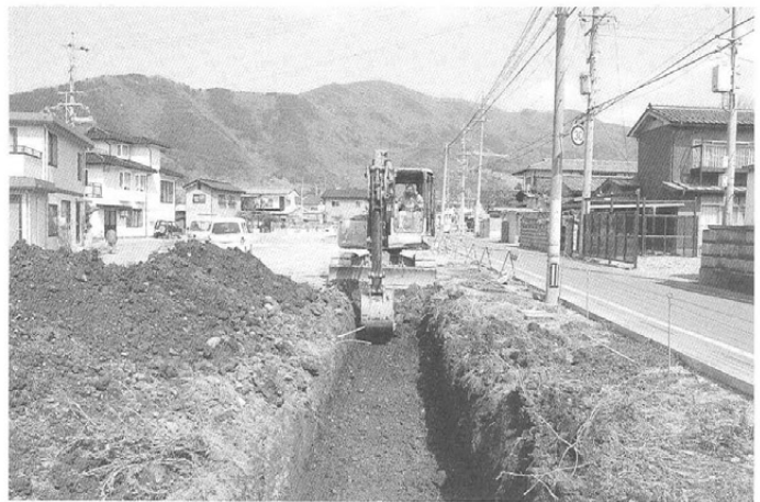
1号トレンチ掘削状況 (南より)
