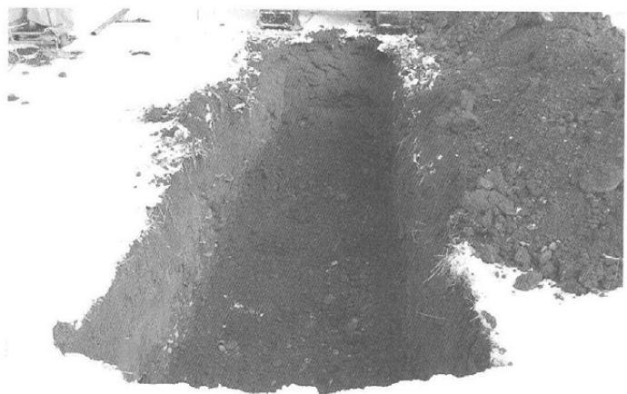
トレンチ検出状況 (西より)
