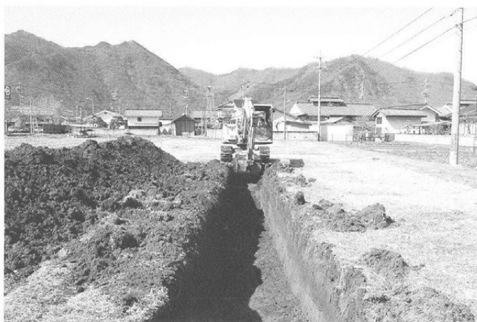
トレンチ掘削状況 (東より)
