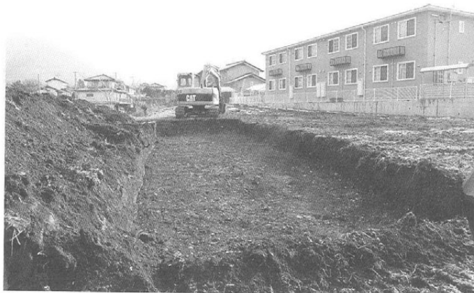
トレンチ検出状況（西より）
