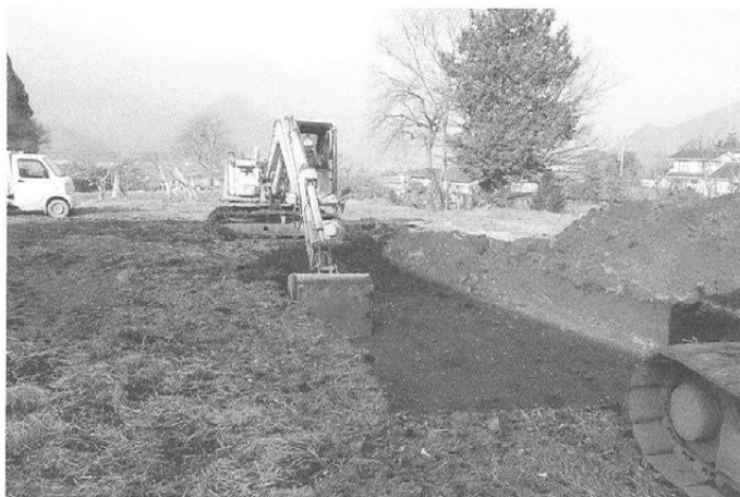
トレンチ掘削状況（東より）
