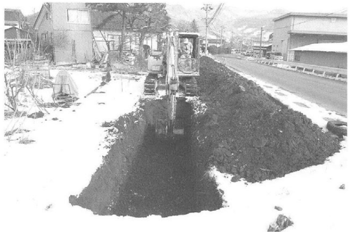
トレンチ掘削状況 (西より)
