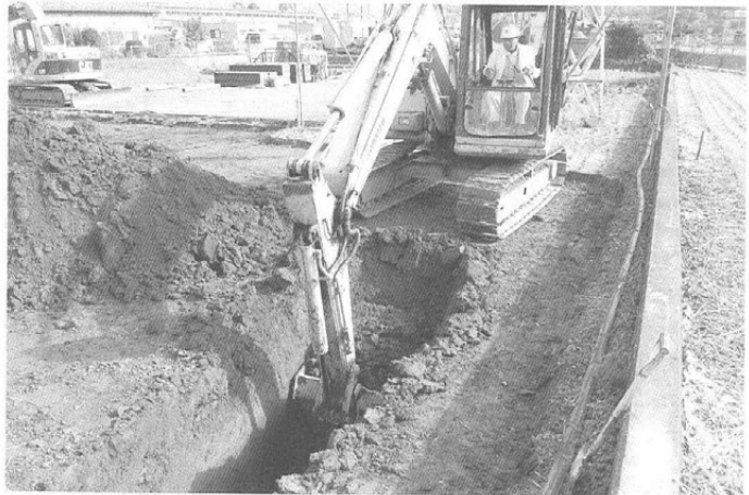
トレンチ掘削状況（西より）
