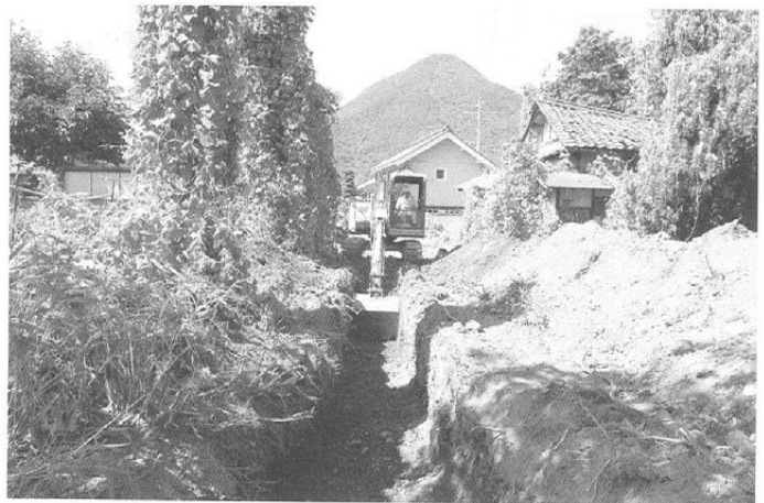
トレンチ掘削状況 (東より)
