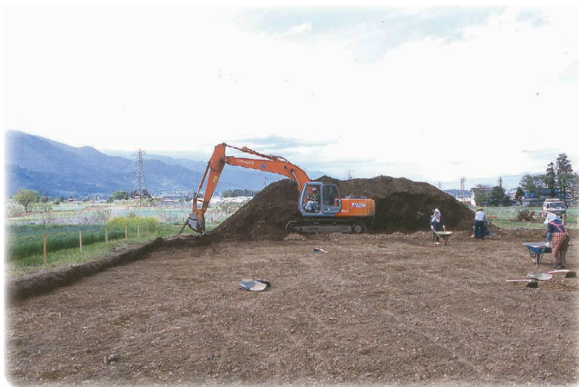
重機による表土剥ぎ
