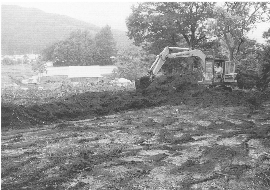
調査地区表土除去
