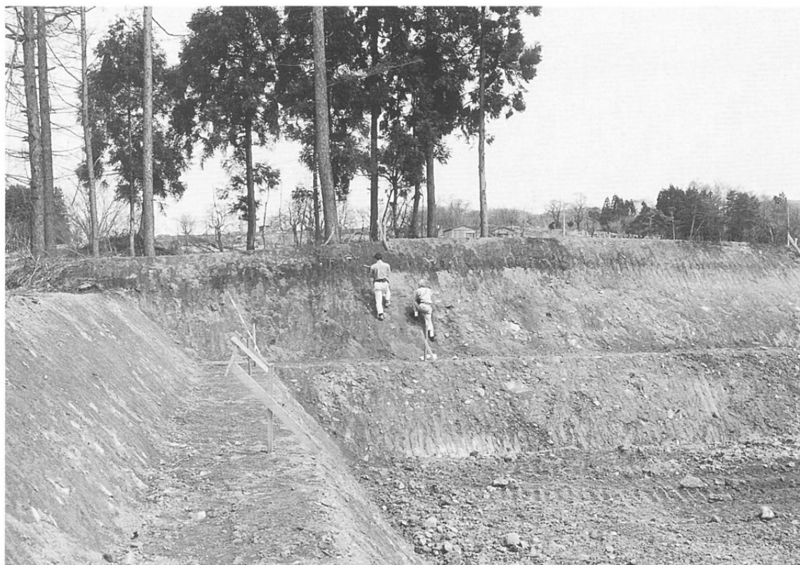
地質調査（工事施工後）
