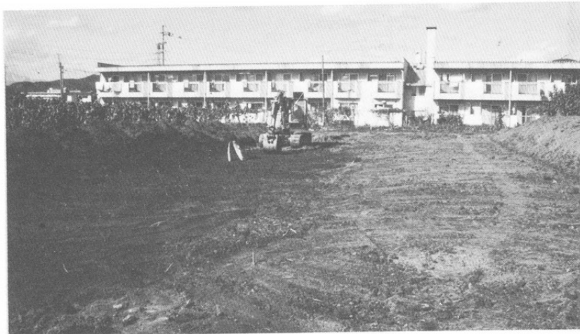
発掘状況 表土はぎ
