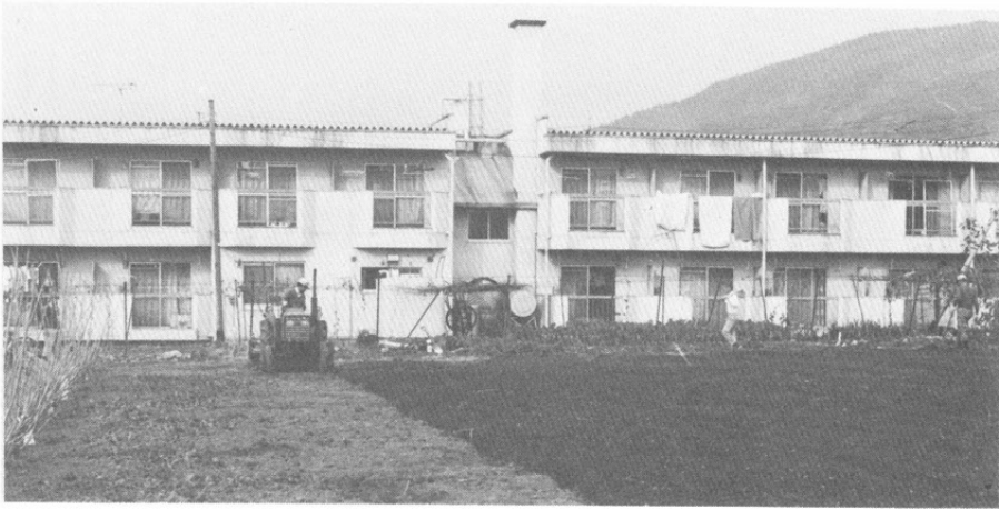
埋め戻し作業
