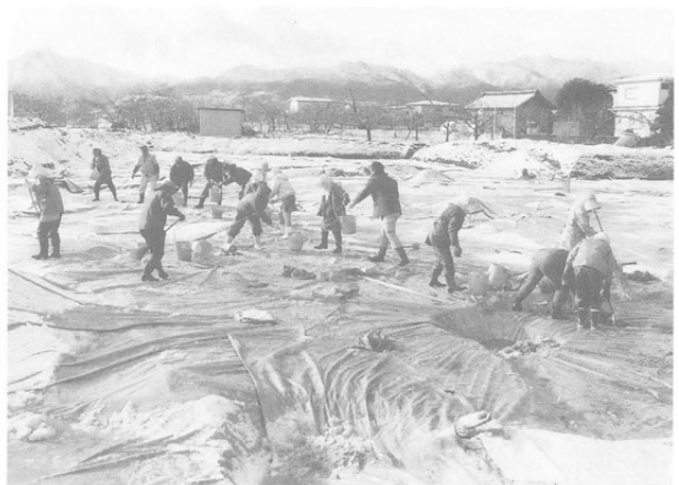
第5写真 2-1区での除雪作業
