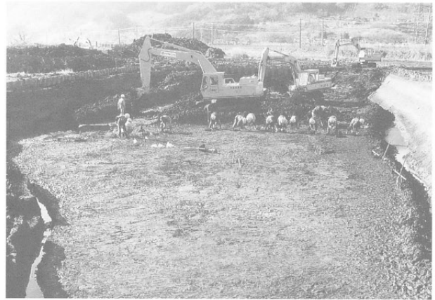
第1写真 20-1区の調査風景
