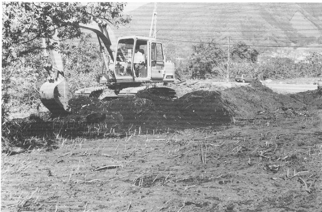
写真4 重機による表土除去作業
