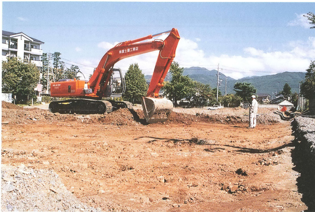
重機による表土除去
