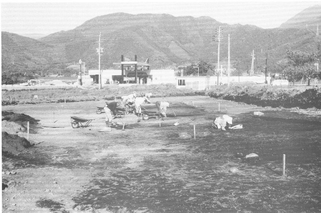
写真22 〇地点調査風景
