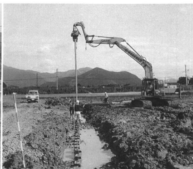
止水用鋼矢板の敷設
