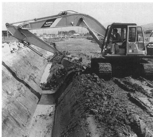
重機による法面の掘削
