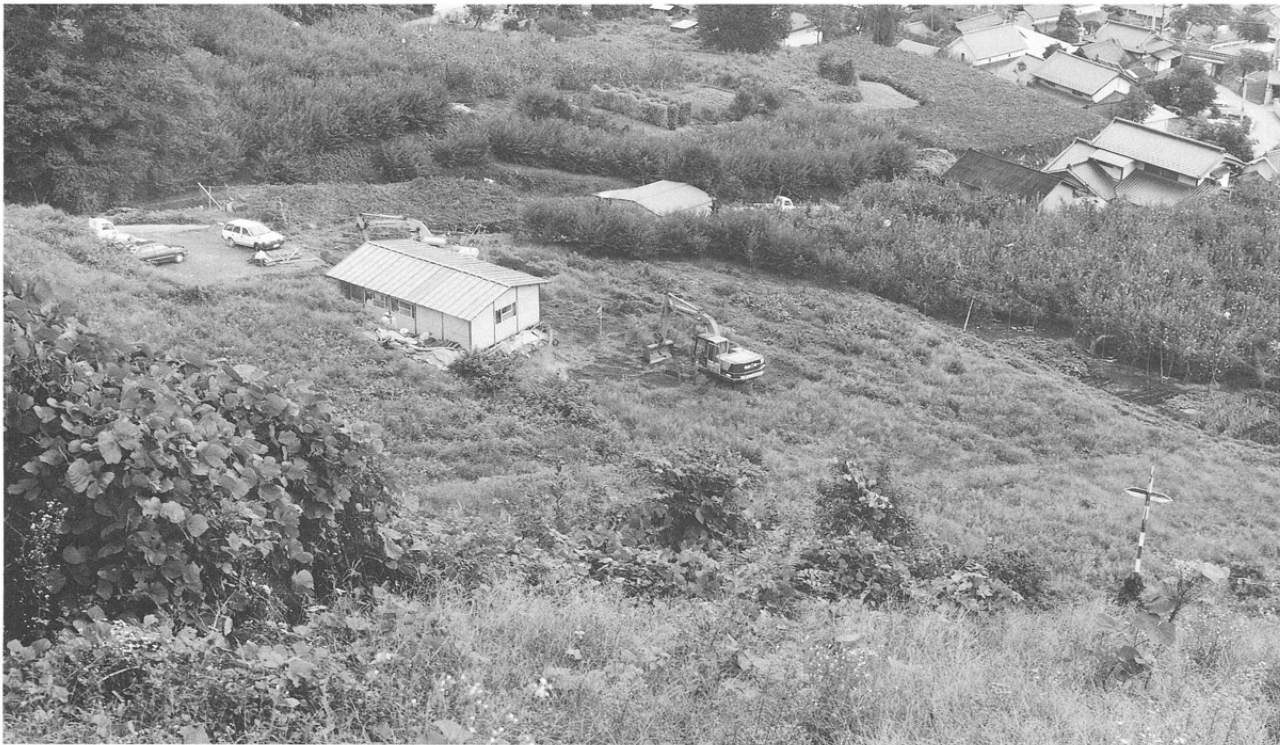
東区全景(西から)
