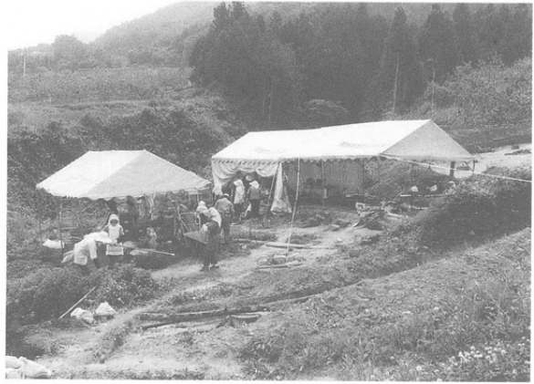
作業風景（平成元年6月）
