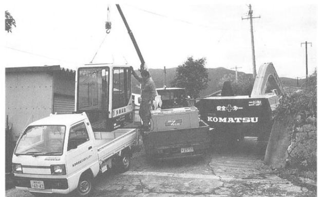
重機の進入 (平成元年9月)
