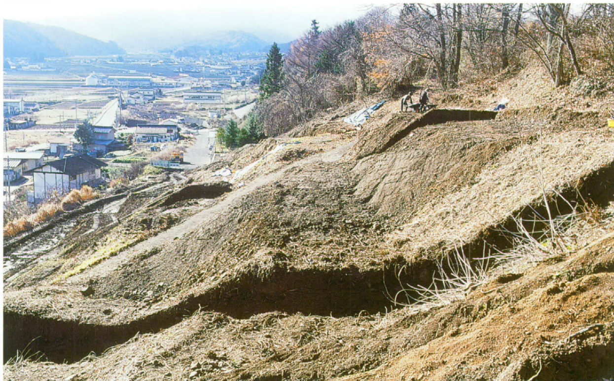
南東斜面部（4区）調査風景、春日城跡方面を望む（平成15年度）
