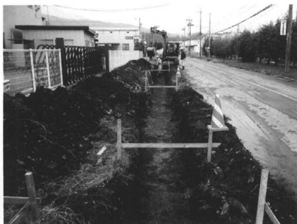
1 村道1号線立会い調査状況
