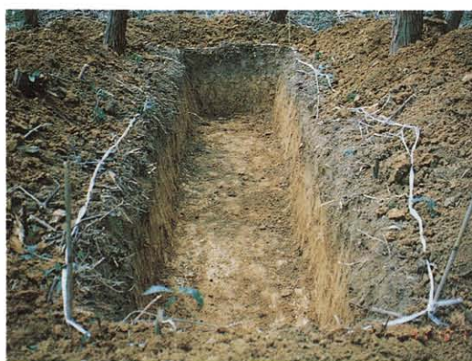
⑤E地点、トレンチ状況
