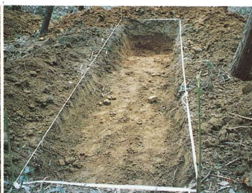
⑥トレンチ状況
