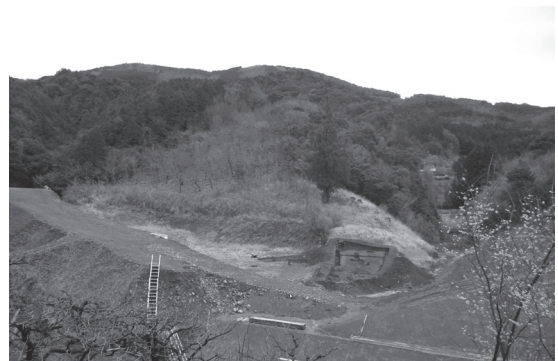
調査区完掘状況
