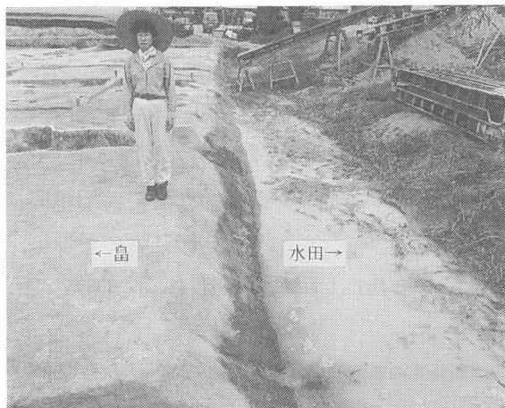
図35 条里方向に従い削平（カット）された埋没丘陵（西より）
