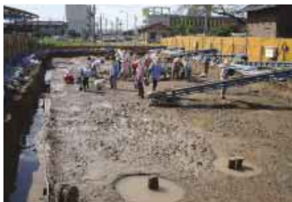
写真2 G a区調査状況
