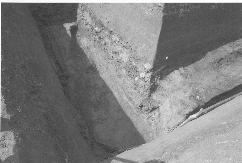
NR03掘削状況(東から)
