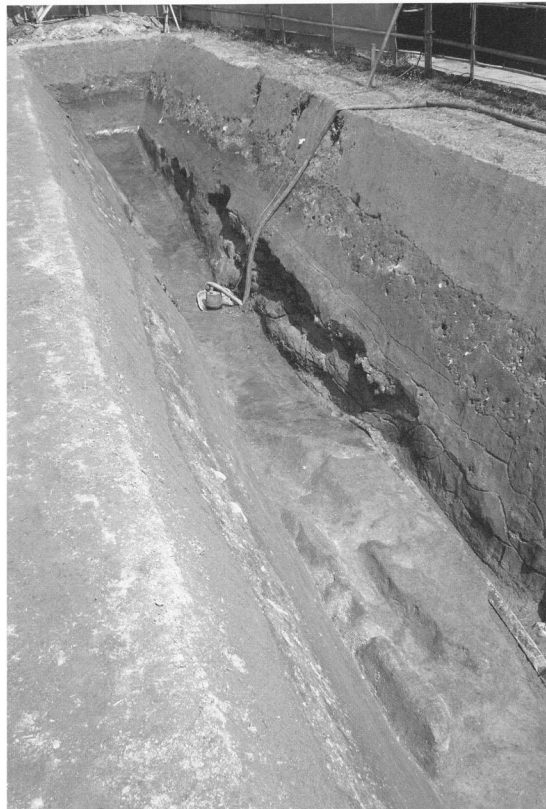
NR01掘削状況(拡張後・南から)
