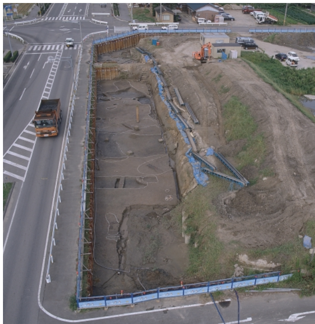
⑤調査区全景(南西より)
