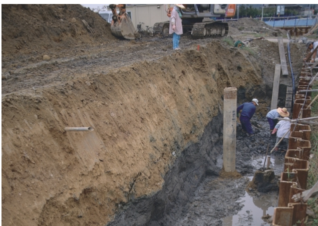
②C遺構群付近作業風景
