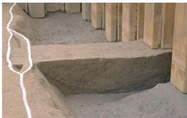
②SD01断面 (北東より)
