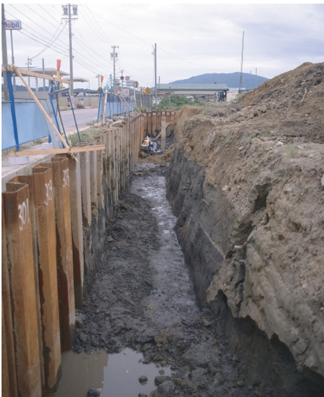
③調査区東側作業風景
