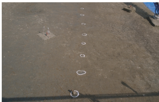
④SA01 (北西より)
