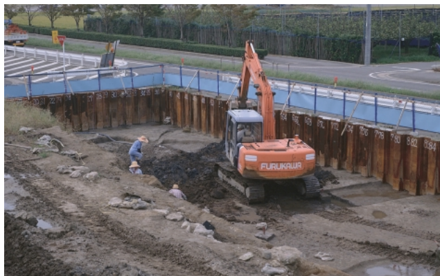
⑥湧水層確認堀削
