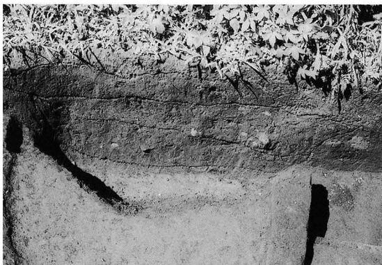
p95住2号断面（東から）
