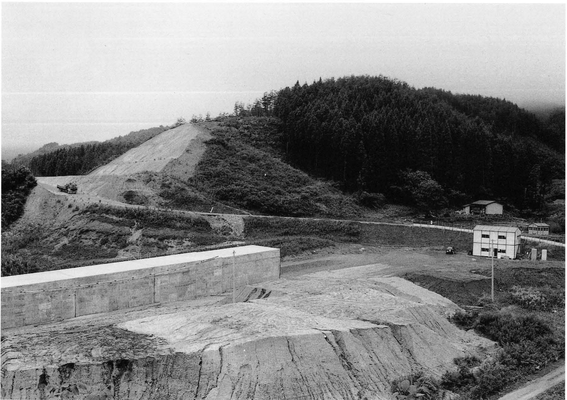
遺跡近景（南東から）
