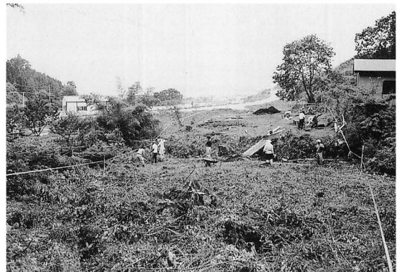
調査前風景（北から）
