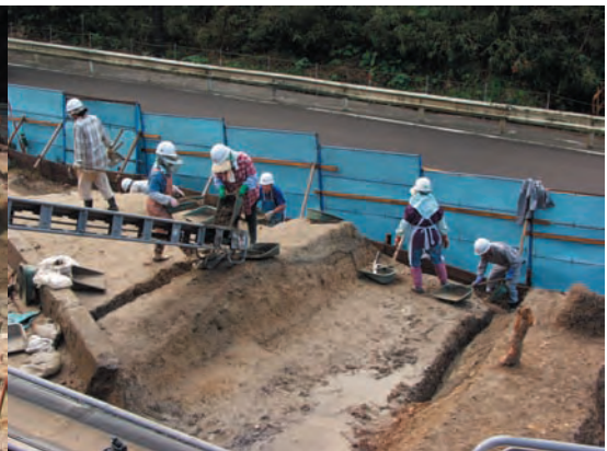
写真5 川合D窯跡作業風景
