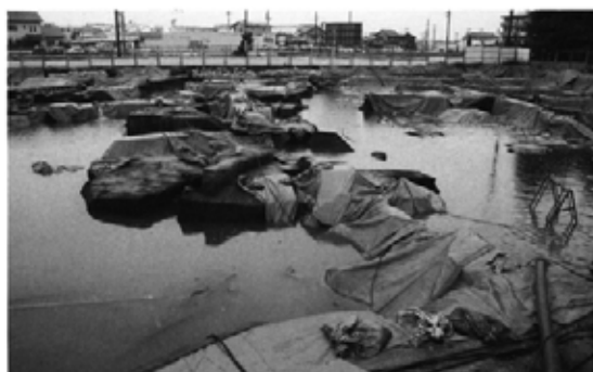
写真1 95調査区湧水状況
