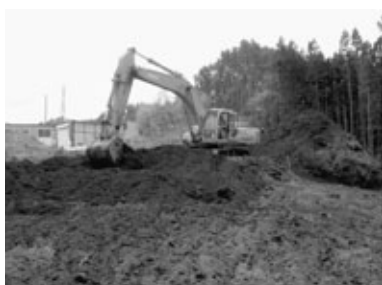
三内地区：近景
