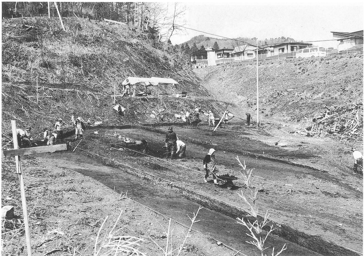
作業風景 (右上は国道45号線)
