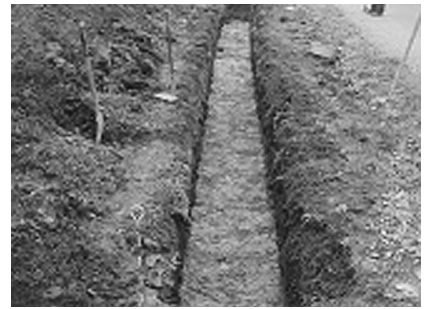
川原館遺跡外B区4T (E→)
