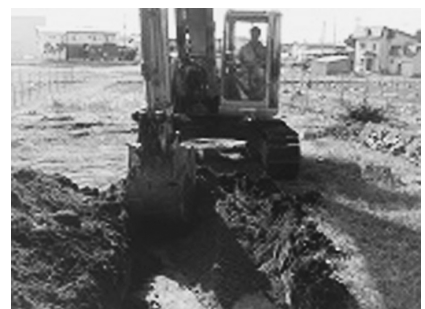
中屋敷遺跡作業風景 (N→)
