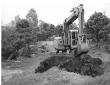
山元 (3) 遺跡① 1T 調査風景 (北→)
