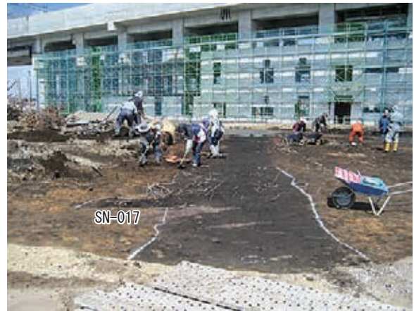
写真4-689 F-2区SN-017周辺作業風景(SW→)
