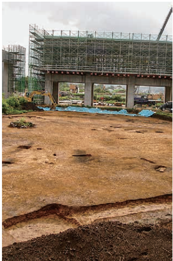
写真4-83 B-2区調査区風景(E→)
