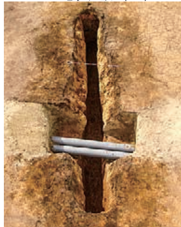
写真4-286 D-1区STP-002完掘(E→)
