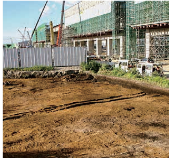
写真4-34 A-3区調査区風景(N→)
