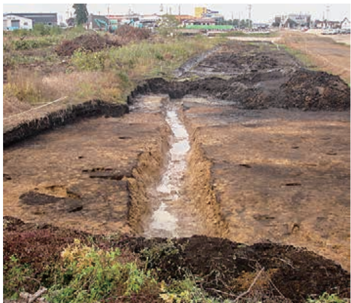
写真4-37 A-4区SD-51b完掘(S→)
