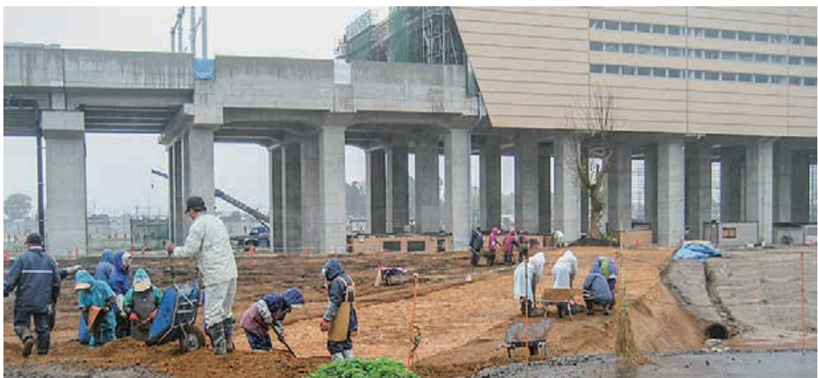
写真4-783 G-1区作業風景(NW→)
