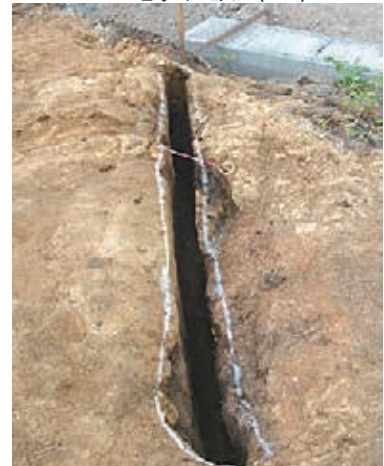
写真4-288 D-1区STP-011完掘(W→)
