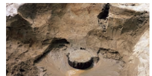
301SE 井戸側(南から)
