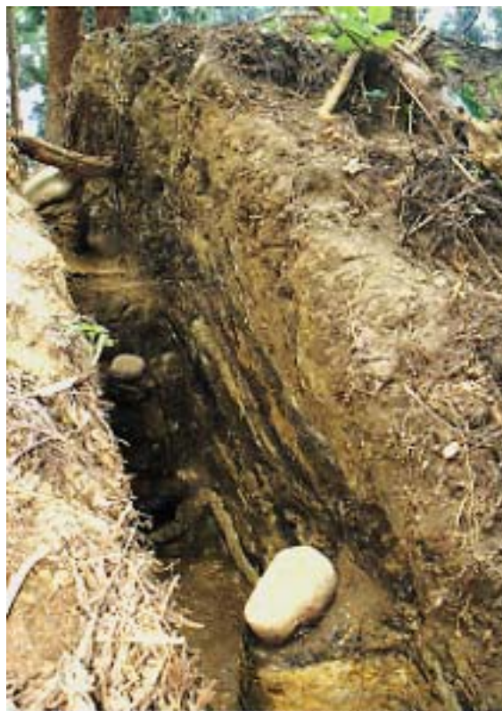
盛土の堆積状況
