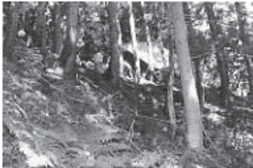
盛土の調査 (E W)
