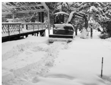
桜峯(1)遺跡調査前風景(北西→)
