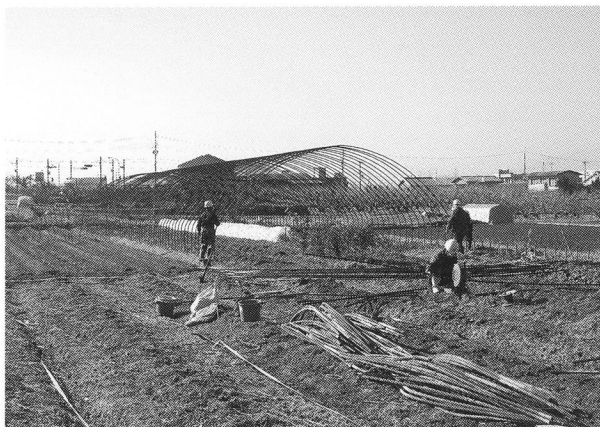
ビニールハウス撤去作業
