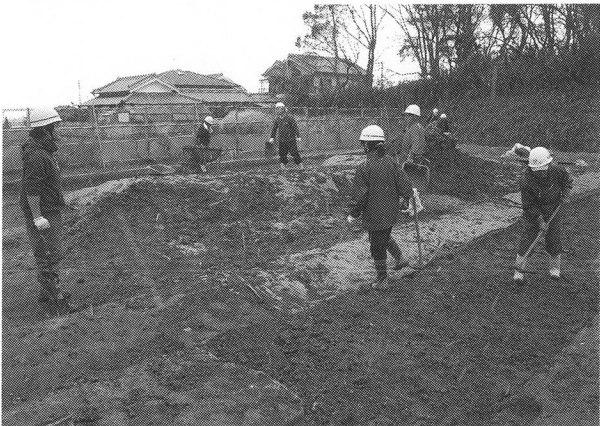
埋め戻し作業
