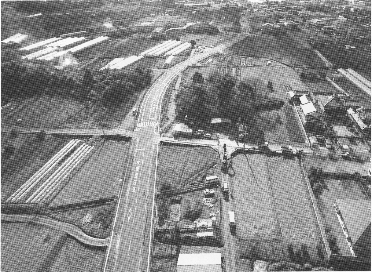
調査地遠景(北から)
