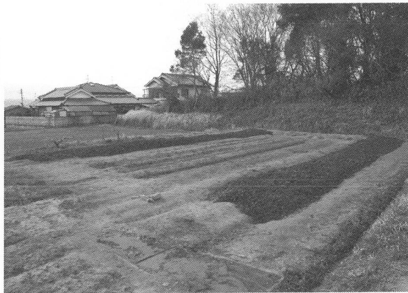
埋め戻し完了
