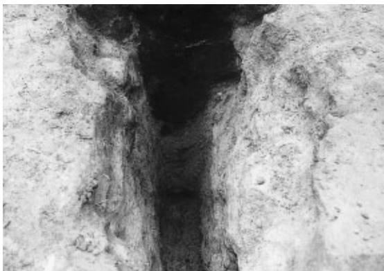
写真64 SP - 101 ( T - Pit ) セクション ( E )
