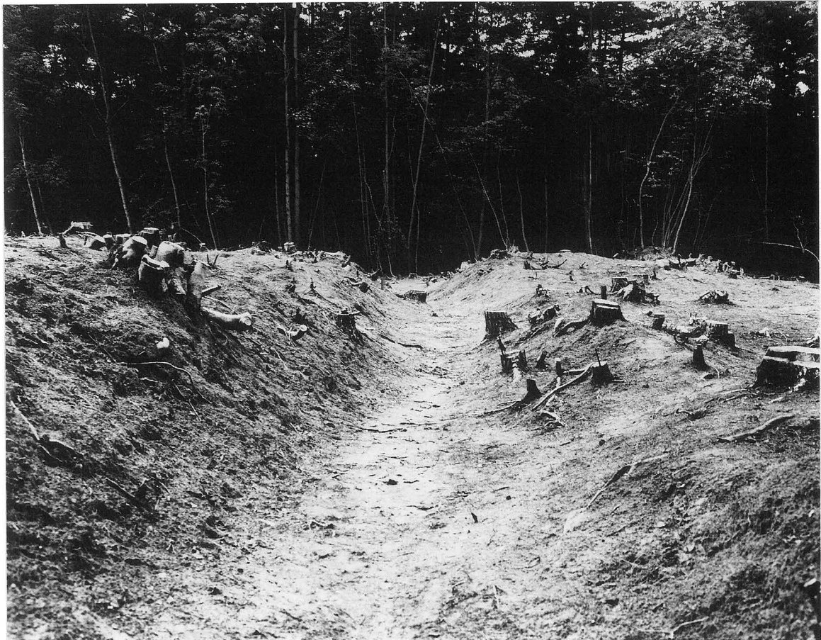
参道跡全景(北から)
