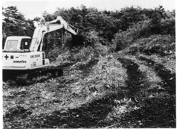
B区雑物撤去状況
