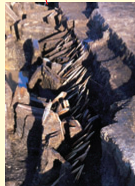
土砂が崩れない ため の杭列
