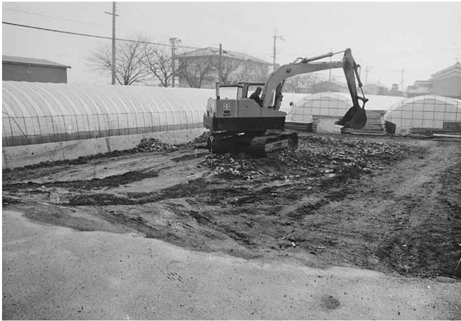
1. 調査前の状況
