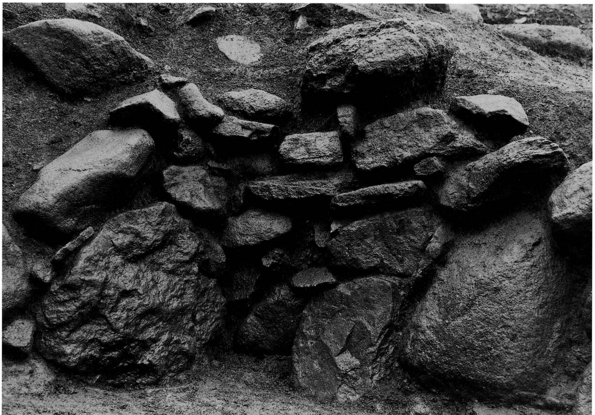
②旧石積み角の状況
