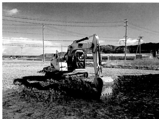
バックホーによる表土掘削 (11月21日)
