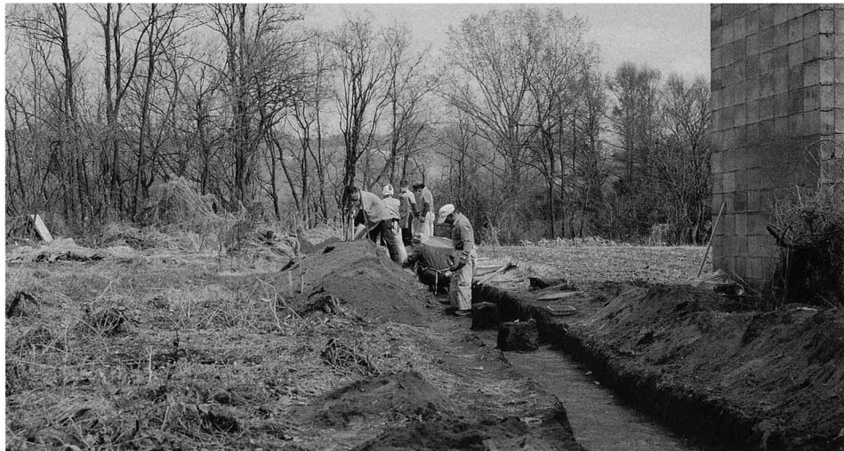
B地区作業風景
