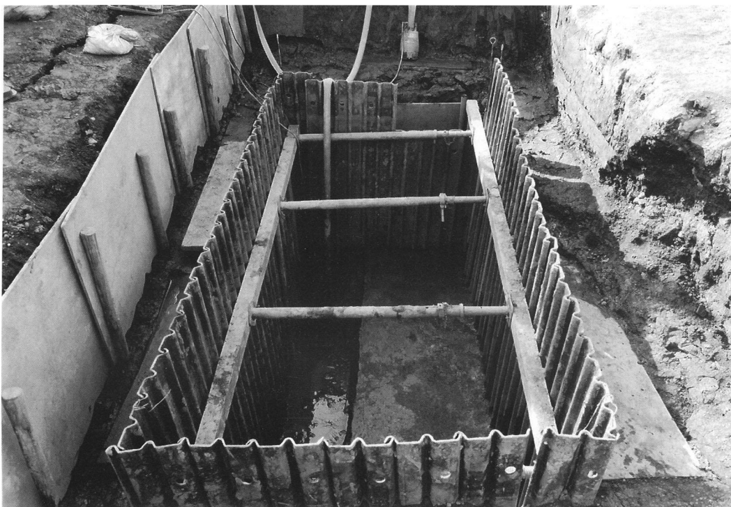
南調査区深掘り部分完掘状況(東から)
