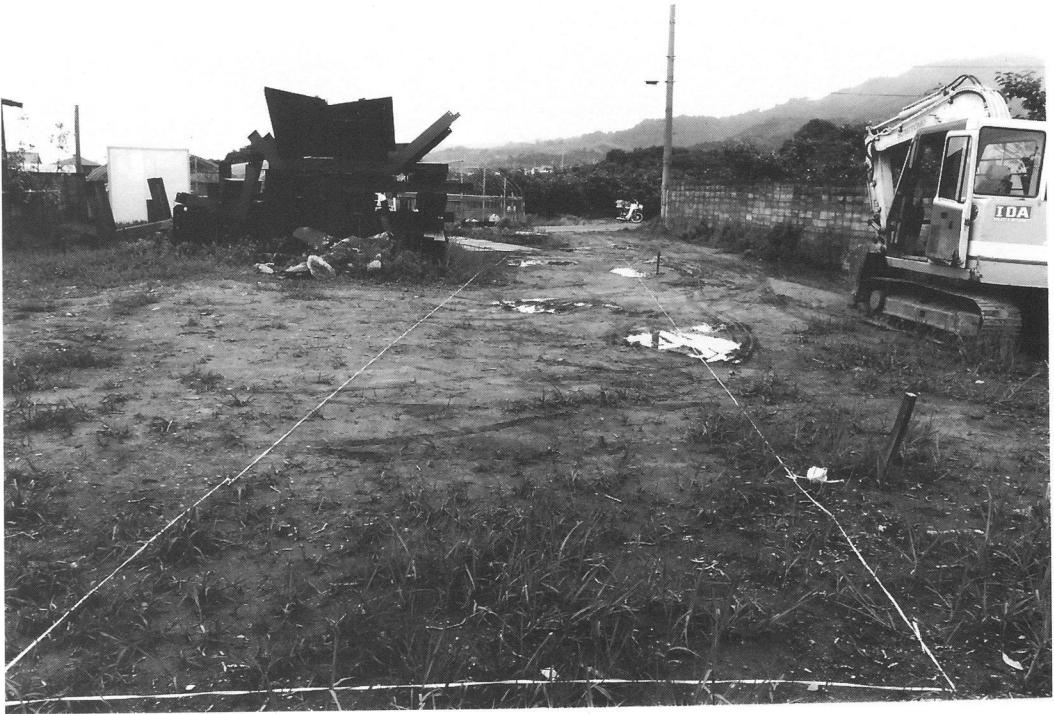
調査前全景(南から)
