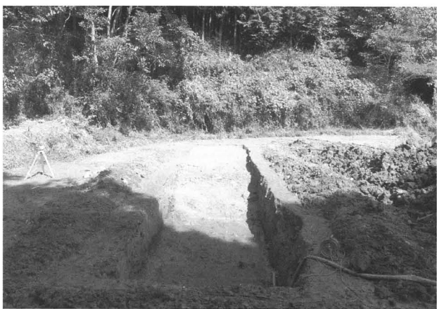
第6発掘区（南西から）
