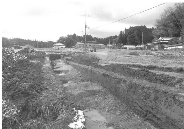
第6発掘区全景（北東から）
