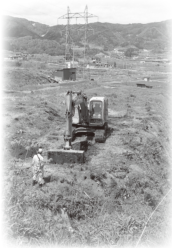
バックホーによる遺跡範囲の確認
