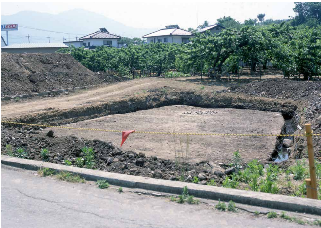
XIX F12区 全景 北より
