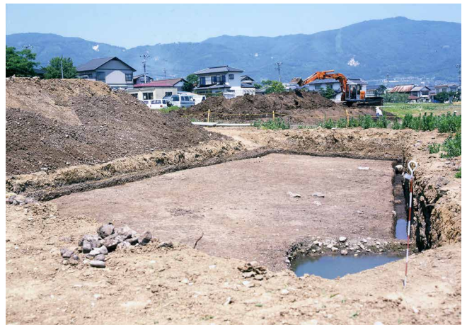
XIX F区東側 全景 南より
