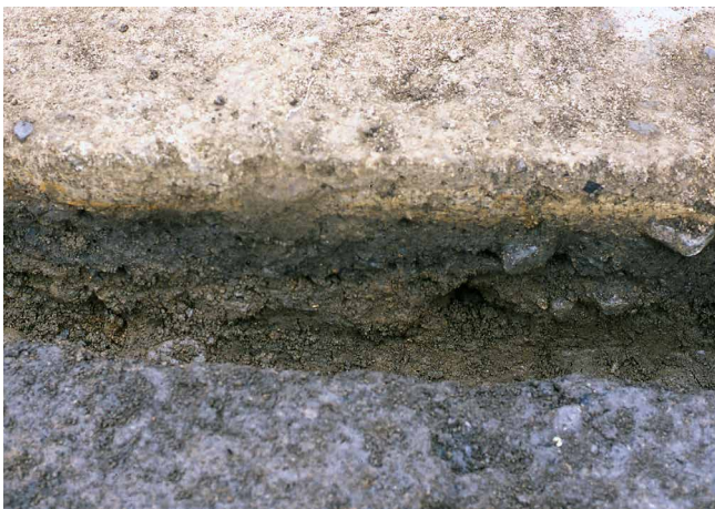
ST38 断面 西より
