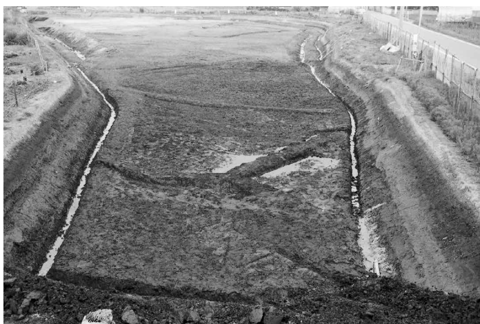
3. ⑤区 水田B SC520~522 (北西より)
