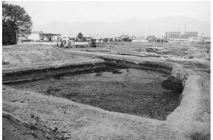
4. ①-3区 全景 (西より)
