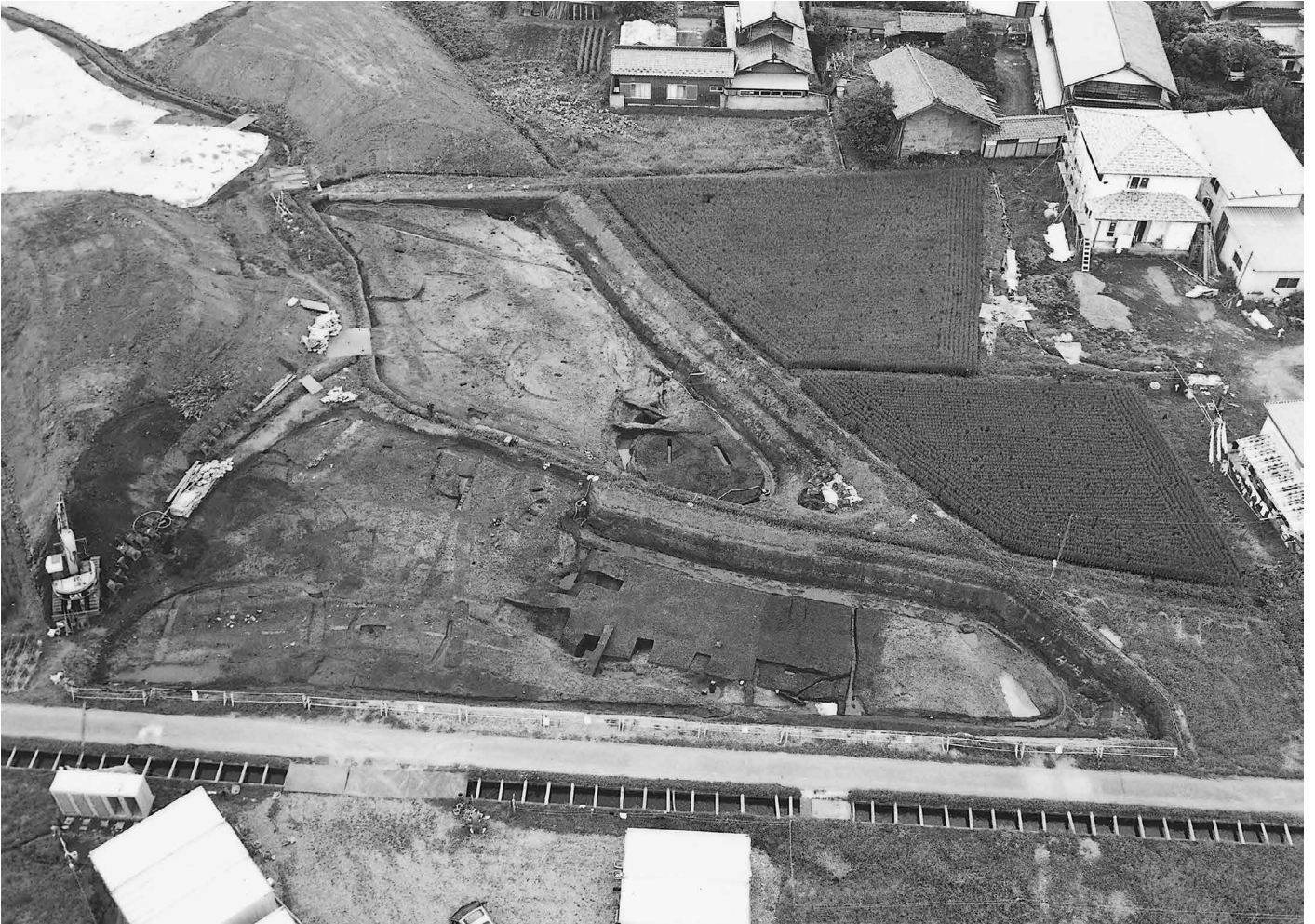
1. ②-2区・③-2区 第3調査面（北東より）
