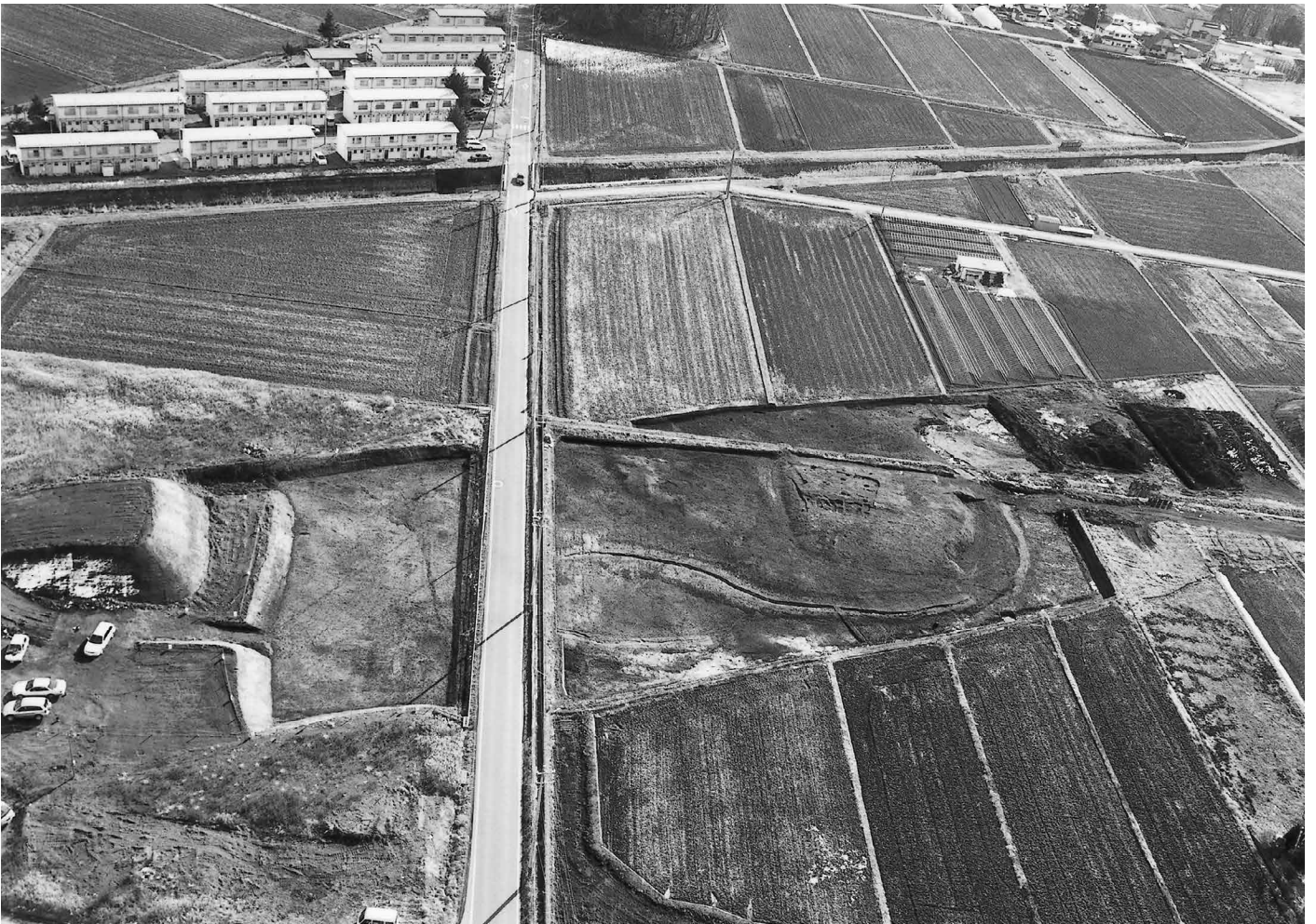
2. ⑥区 第2調査面（北東より）
